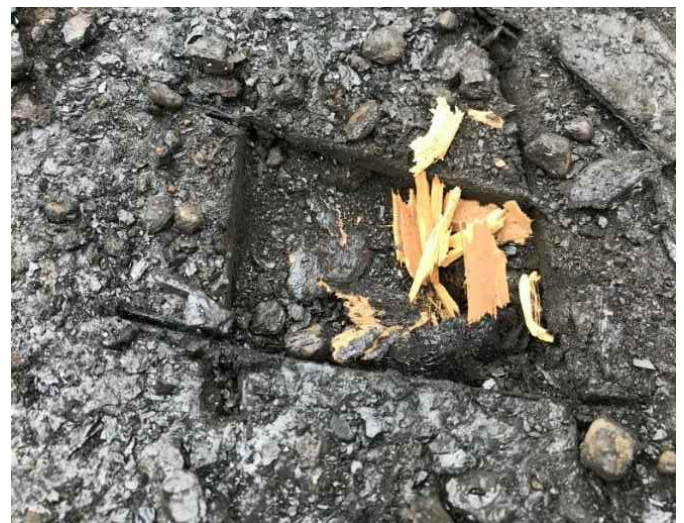
9 CORE CUT ROOF 'G' A-300 SCALE: N.T.S.
