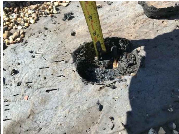
3 CORE CUT ROOF 'B1' A-300 SCALE: N.T.S.
