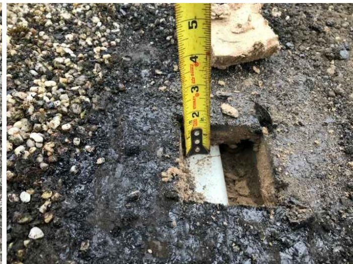
12 CORE CUT ROOF 'I' A-300 SCALE: N.T.S.
