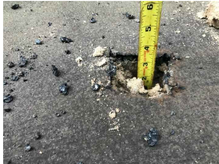
2 CORE CUT ROOF 'B' A-300 SCALE: N.T.S.
